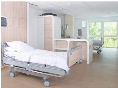
Innenansicht Zweibettzimmer mit freeAir Lüftungsgerät
