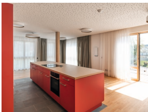
freeAir Lüftungsgerät in der Gemeinschaftsküche
