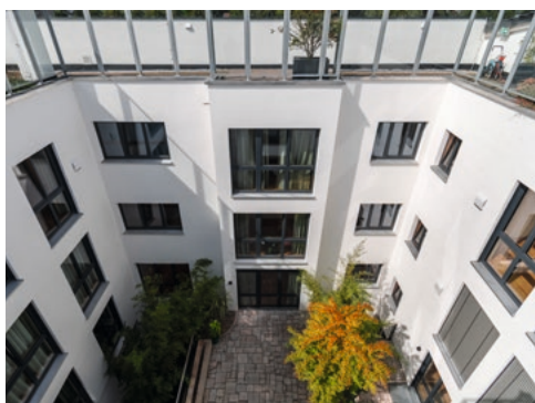
Weißer Außenhauben im Innenhof
