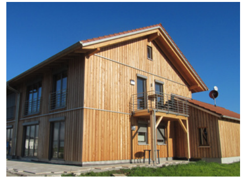
Die Außenhaube fügt sich gut in den Gesamtlook der Fassade mit dem Balkon ein
