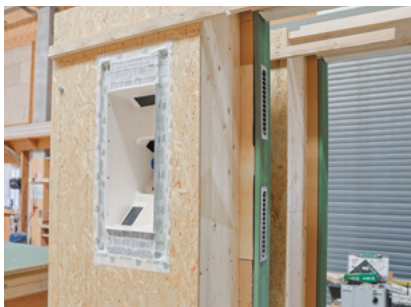
Rohbauset für Fensterlaibung ab Werk integriert
