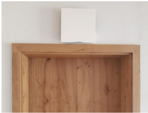
Unauffällig aber wirkungsvoll: Der freeAir plus über einer Zimmertür → Dank des Überströmers keine Zuluftleitung
