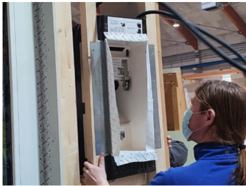
Das Rohbauset wird mit Hilfe der Holzbauwinkel in eine Holzständerwand integriert
