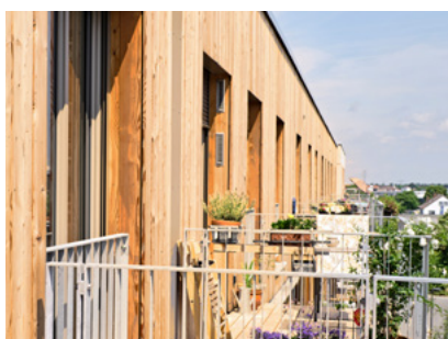
Edelstahlgitter der Fensterlaibungslösung
