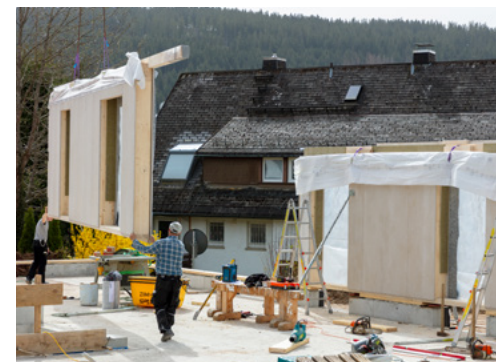
Baubeginn mit den ersten Wänden
