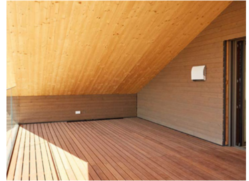
Außenhaube am großzügigen Balkon
