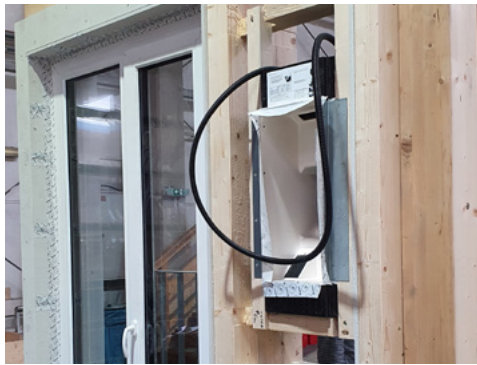
Schön zu sehen: Das Rohbauset wird mit allen Anschlüssen und Verrohrungen im Werk installiert
