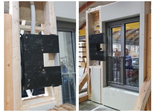
Die freeAir Fensterlaibungslösung ab Werk integriert, mit Außen- und Fortluft am bodentiefen Fenster
