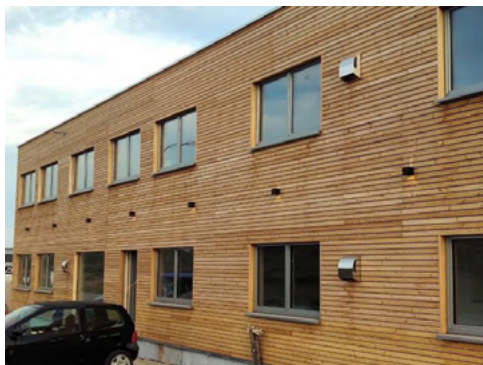
Ein Bürogebäude in Holzständerbauweise
