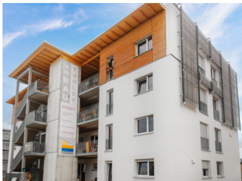
„Höchstes Holzhaus Mannheims“ - der Turley Bau, günstiges Wohnen mit Niedrigenergieanspruch
