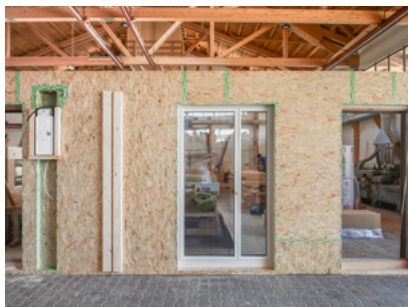
Rohbausets in der Holzwand
