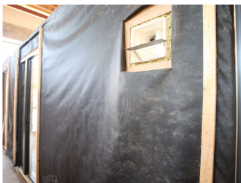
Auch der Anschluss für die Außenhaube kann direkt in die Wand erfolgen
