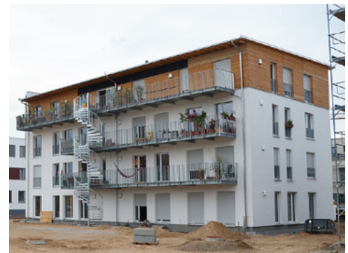
Ein Gerät pro Wohneinheit, vollautomatische Lüftung für alle Bewohner und voll getrennte Brandschutzbereiche ohne Klappen möglich
