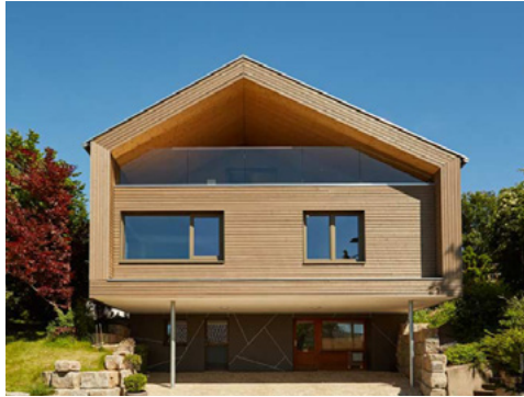
Sanierungsprojekt der Firma Heinzelmann
