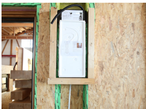
Hier ein Einbau ohne Metallwinkel direkt ins Holz
