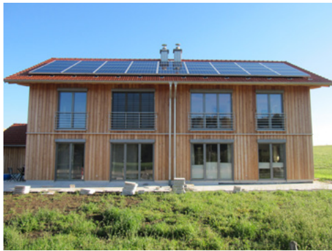
Moderner Holzbau mit Niedrigenergieansatz und Photovoltaik Anlage → Perfekte Ergänzung: das hocheffiziente freeAir Lüftungssystem mit > 90 % Wärmerückgewinnung
