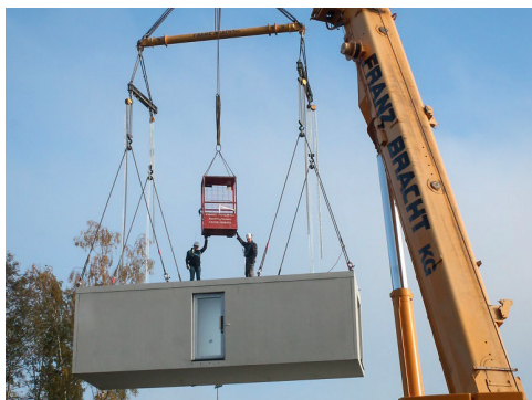
Aufstellen eines der Module
