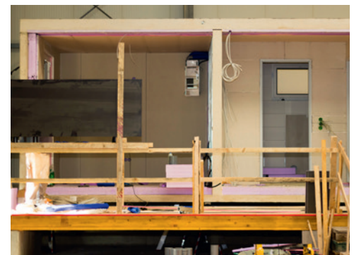
Ab Werk installiertes Rohbauset für den Plug&Play Betrieb des freeAir-Lüftungssystems
