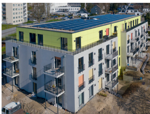
Photovoltaikanlage für die Stromversorgung
