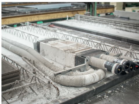
Das Rohbauset wird werkseitig in die Fertigwand integriert - Hier direkt in die Betondoppelwand eingegossen
