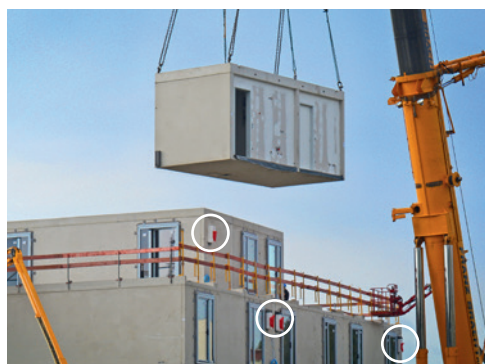
Beton-Modulbauweise, Rohbausets werden bereits ab Werk in die Module eingegossen
