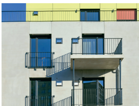
Edelstahläußenhauben passend zur Sichtbetonfassade
