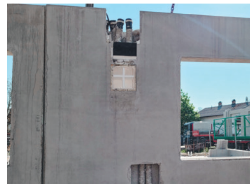
Setzen der Fertigwand inklusive aller Leitungen
