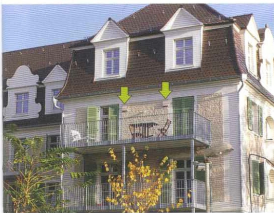
Außenhauben der »freeAir 100« Lüftungssysteme passen sich dezent an die Fassade der Denkmalschutzwohnungen an (Quelle: blueMartin)
