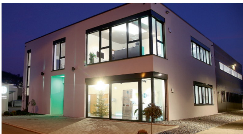
Das neue, rund 920 m 2 große Hummel-Produktions- und Verwaltungsgebäude
