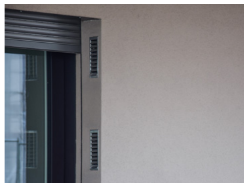
Soluzione di aerazione freeAir 100 nel telaio della finestra
